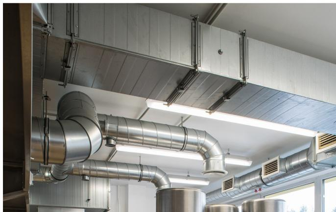
Необходимость установки шумоглушителя в систему вентиляции здания определяют, сделав акустический расчет для восьми октавных частот звука (63, 125, 250, 500, 1000, 2000, 4000 и 8000 Гц). Однако их установка является правом, а не обязанностью проектирующей организации.
